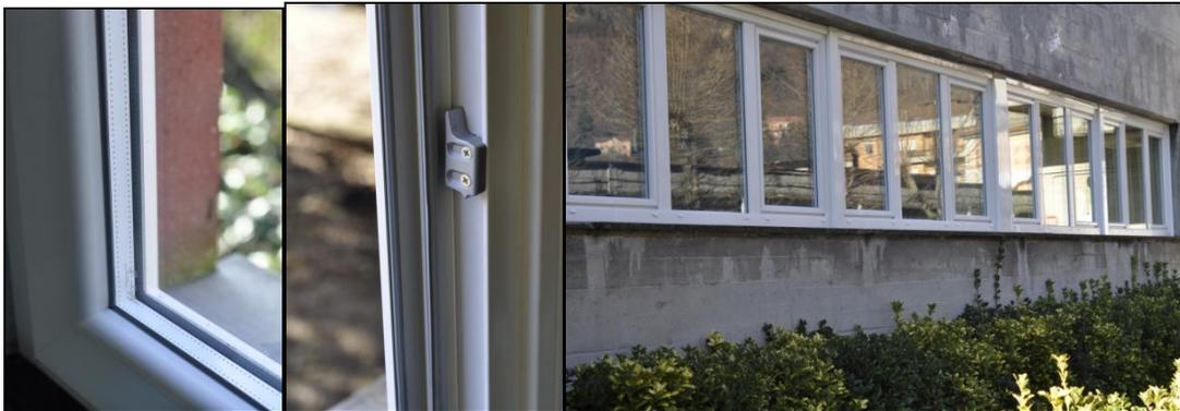
Figura 20: Immagini degli infissi ad elevato potere fonoisolante installati presso l'asilo nido
