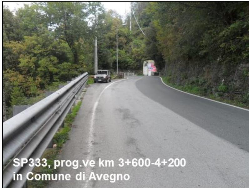
Figura 6: Tratto della S.P. 333 in cui è stata realizzata l'asfaltatura antirumore
