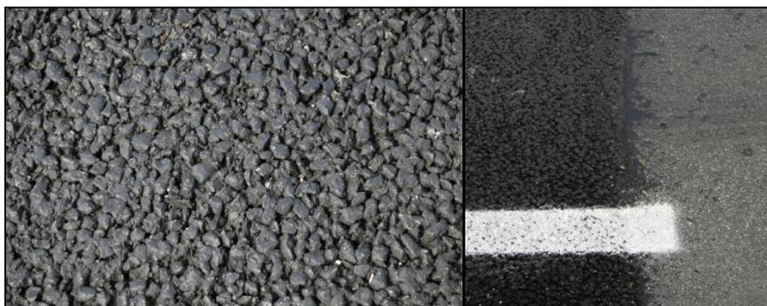
Figura 10: Dettaglio della pavimentazione stradale di nuova realizzazione (sinistra) e confronto con il manto preesistente
