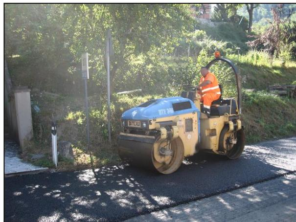
Figura 9: Realizzazione dell'asfalto fonoisolante nel tratto in esame lungo la SP 225
