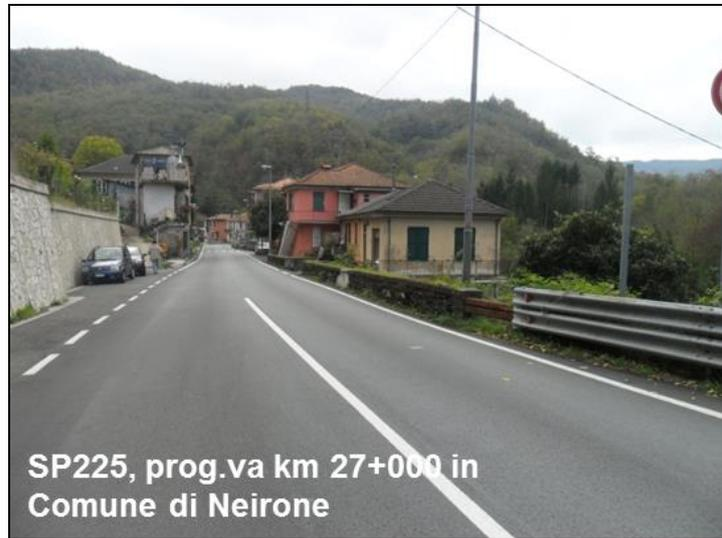
Figura 8: Tratto della S.P. 225 in cui è stata realizzata l'asfaltatura antirumore
