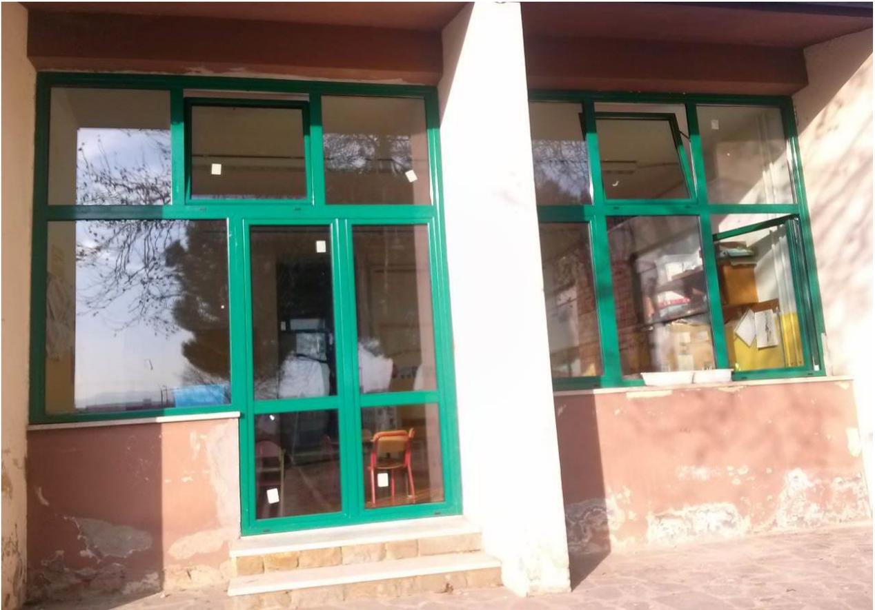
Figura 26: Particolare dell'intervento di risanamento acustico realizzato presso la Scuola "Meoni"
