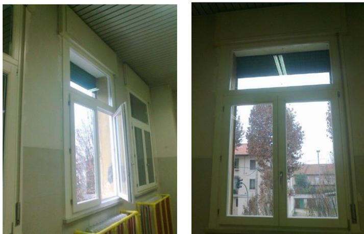
Figura 21: Immagini delle finestre ad elevato potere fonoisolante installate presso la Scuola Elementare Cabianca
